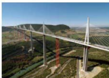
Viaduc de Millau (Aveyron) en France Le pont le plus haut du monde, inauguré en décembre 2004 Depuis 2002, le site a accueilli plus de 500 000 visiteurs
